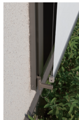
サッシ取付け時 下部アップ
