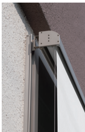
サッシ取付け時 上部アップ
