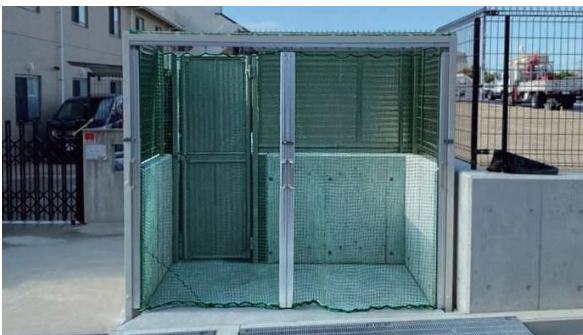
防鳥 ネットカーテン/間仕切ボール
